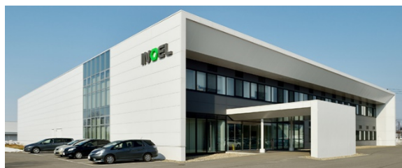
Fig.1 INOEL 建屋全景
